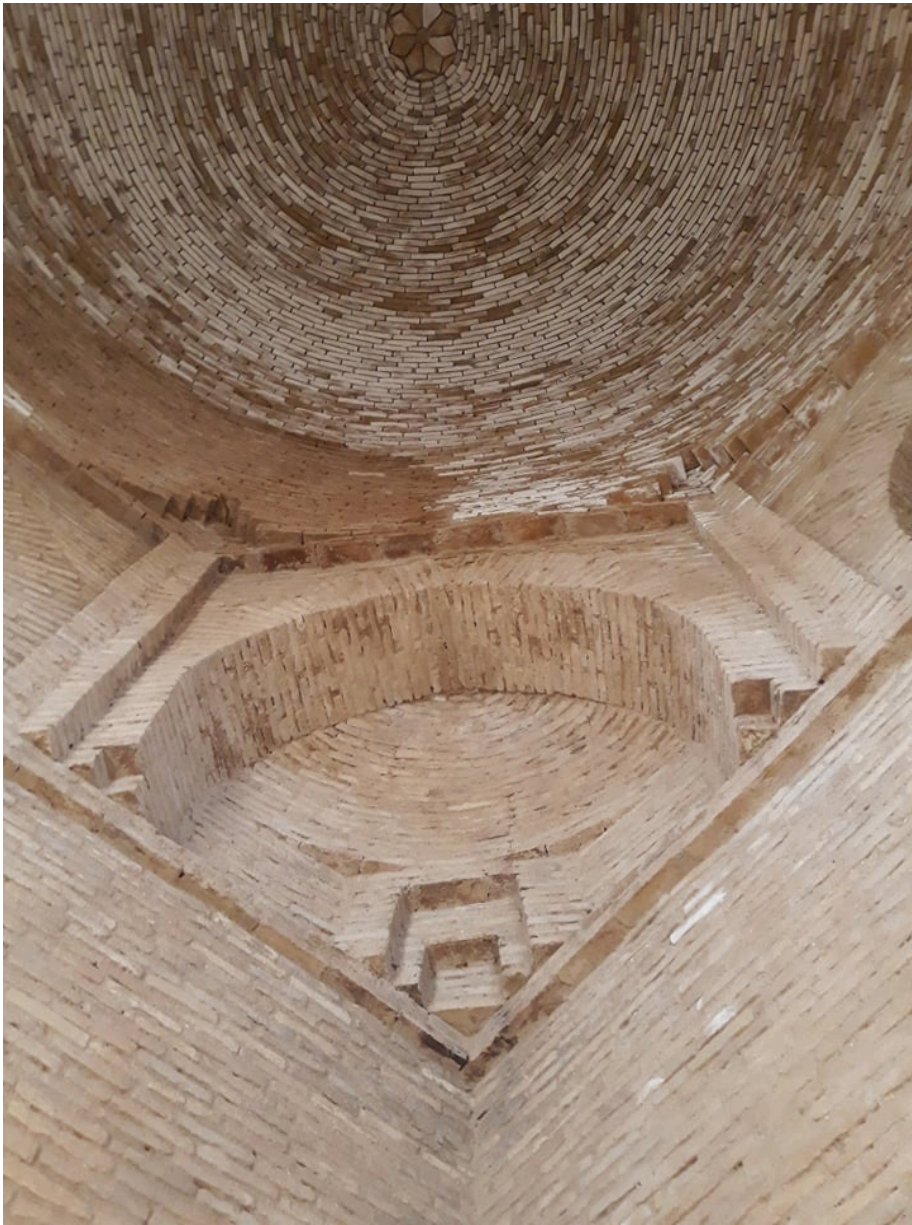
تصویر ۵: مرمت و ایجاد گوشه‌سازی در قسمت ساقه/چپیژه گنبد؛ عکس از همایون احمدی، ۱۳۹۹ خورشیدی
