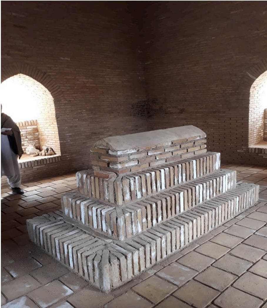
تصویر ۶: مقبره مرمت‌شده قبل از کاشی‌کاری، خشت‌فرش کف بنا نیز قابل مشاهده است؛ عکس از همایون احمدی، ۱۳۹۹ خورشیدی
