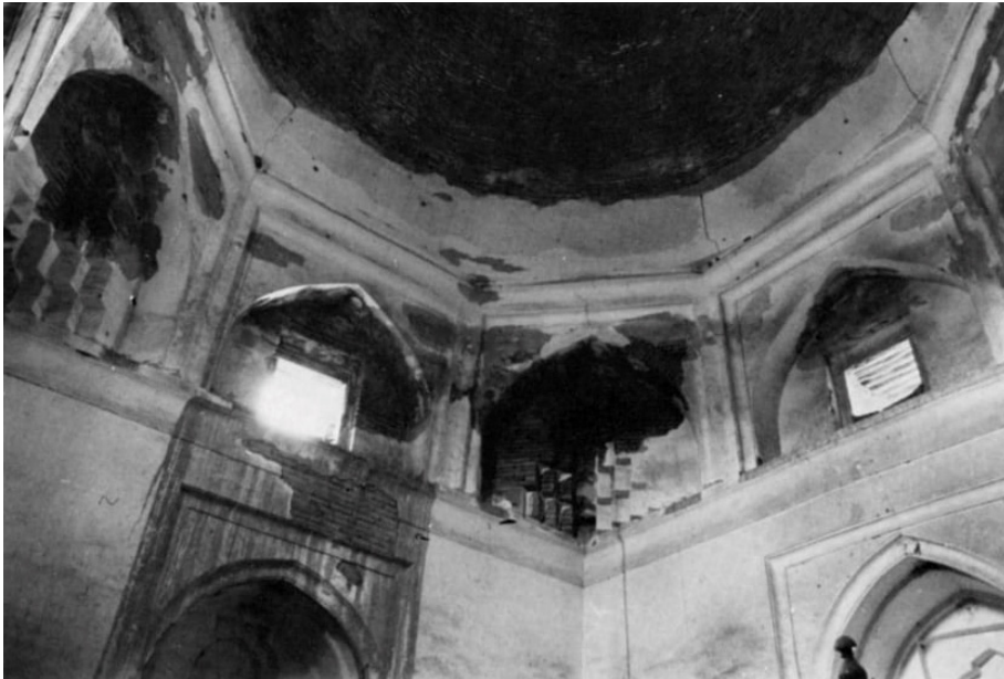
(Pl. XIII a): نمای داخلی و چپیره گنبد آرامگاه نظام الدین در عشق آباد
